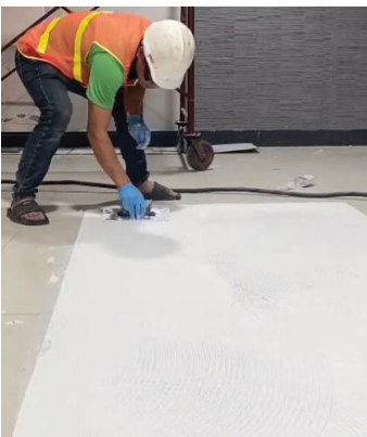
Trải đều keo đã trộn lên tấm (đạt >90% bề mặt tấm)
