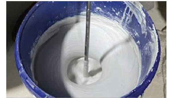
Trộn keo theo tỉ lệ 3 bột:1 nước, dùng máy trộn đều
