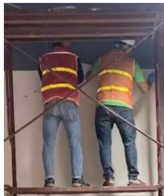
Đặt tấm lên vị trí ốp, căn chỉnh cho thẳng và dùng súng bắn đinh cố định
