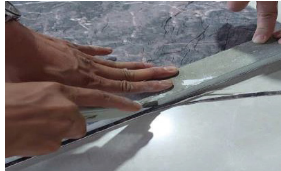
Dùng dao rọc giấy cắt tấm theo kích thước đã đo
