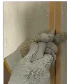
Phủ kín keo vào mạch, bóc băng dính sau phủ keo
